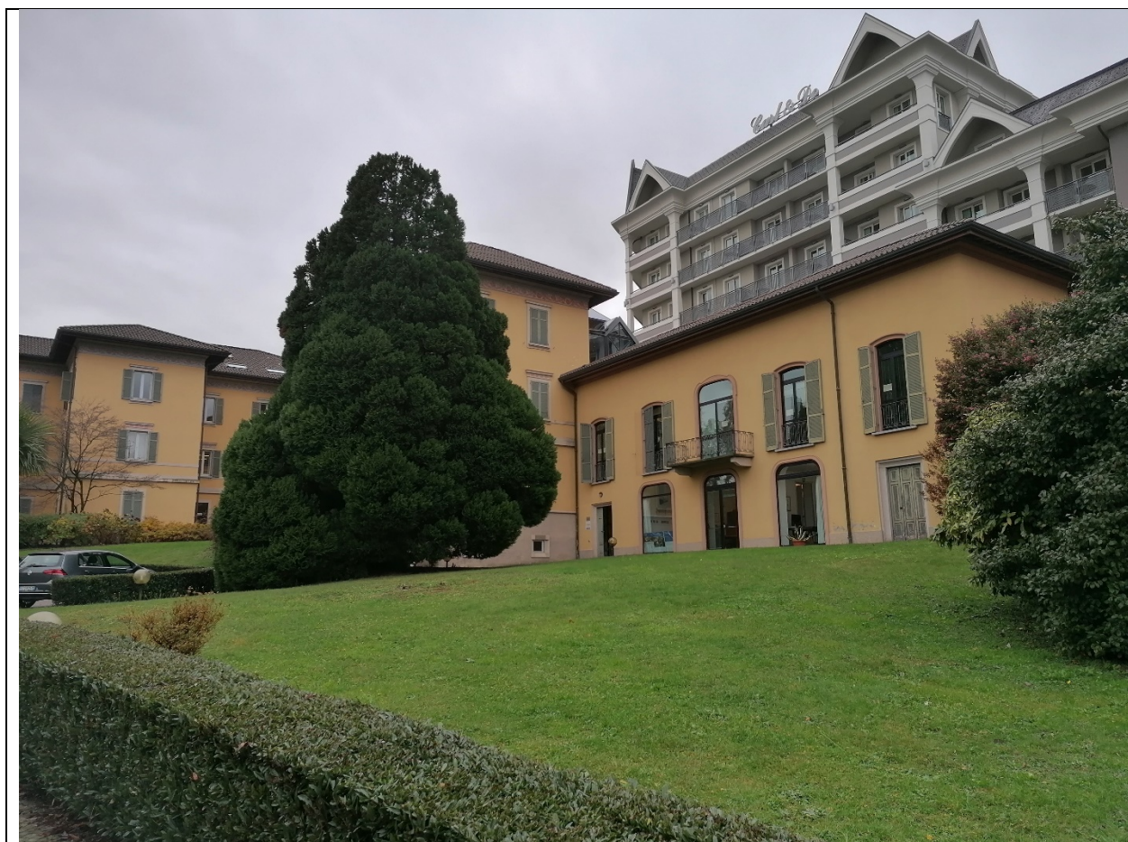
Figura 6 - porzione oggetto di alienazione (2 piano fuori terra)
