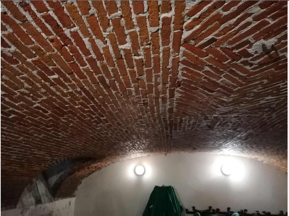
Figura 11 - locale cantina piano interrato
