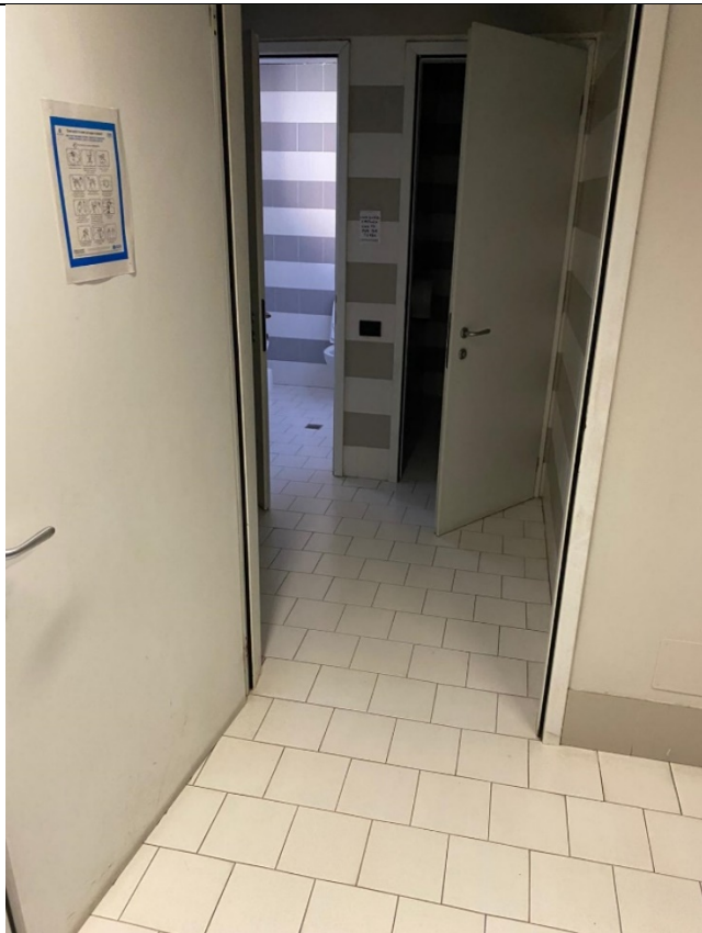
Figura 9 - servizi igienici piano interrato
