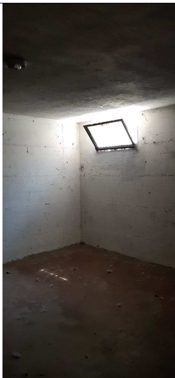
Figura 28 - locale piano interrato
