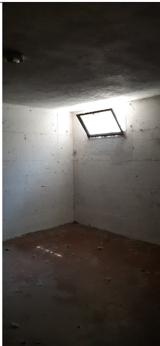
Figura 28 - locale piano interrato
